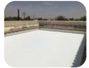
3000m 2 平屋顶涂覆2层550防水薄膜涂层。
