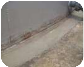
罐体底裙首先涂覆 506 底胶，然后，搭配使用550防水薄膜涂层及增强带。
