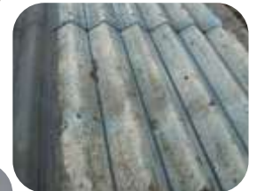
2000m 2 钢制屋顶涂覆2层550防水薄膜涂层。
