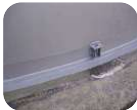
罐体底裙首先涂覆 506 底胶，然后，搭配使用550防水薄膜涂层及增强带。
