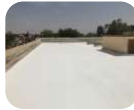
3000m 2 平屋顶涂覆2层550防水薄膜涂层。
