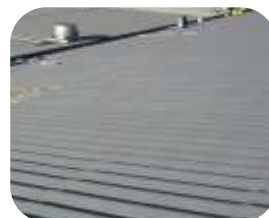
2000m 2 钢制屋顶涂覆2层550防水薄膜涂层。
